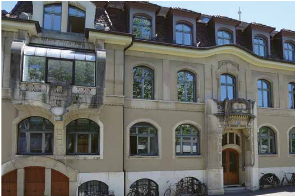
Figure 6.72: Le bâtiment historique date de 1903.
