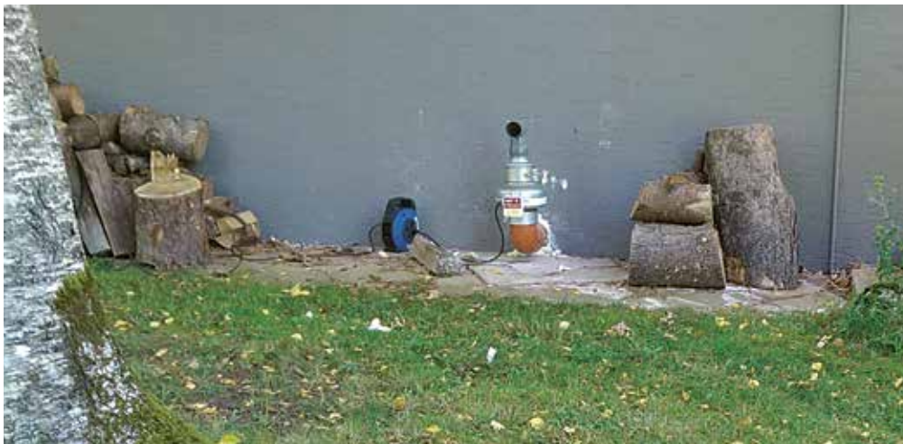
Figure 6.55 : Installation temporaire d'un puisard.
