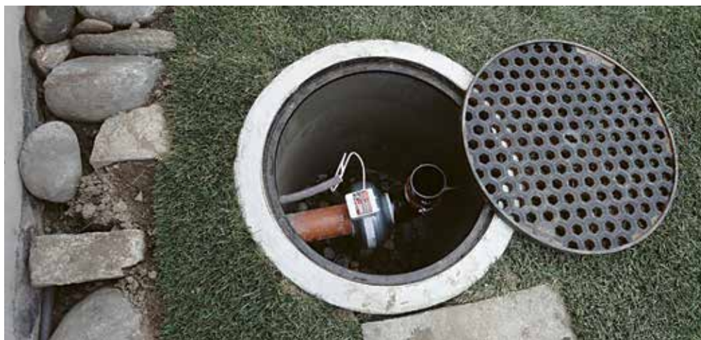
Figure 6.5: La bouche du puisard se trouve à côté de la maison.
