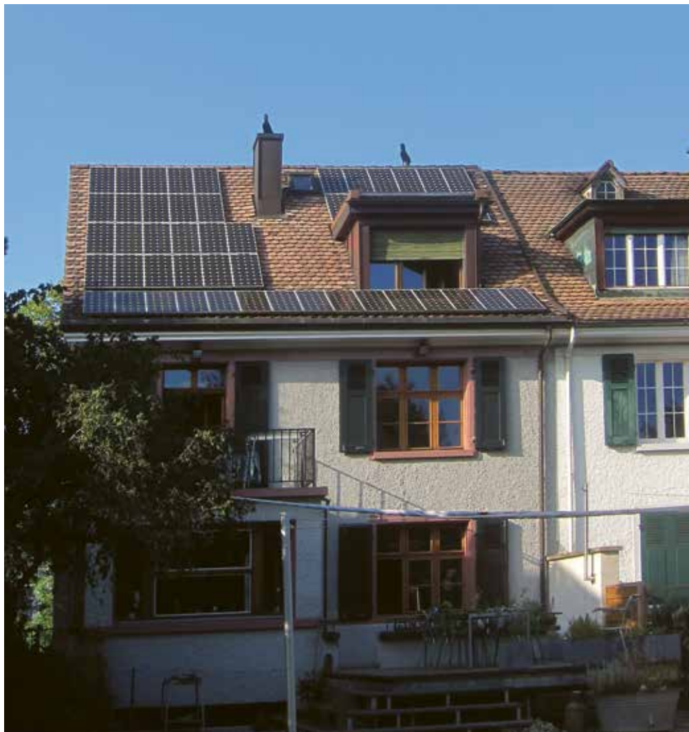
Figure 6.77 : L'installation de fenêtres isolantes étanches a conduit à une péjoration de la problématique du radon dans le bâtiment des années 1920.
