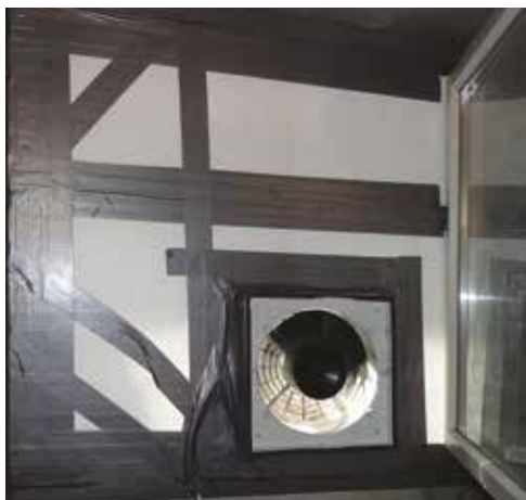
Figure 6.8 (à gauche): Les premiers essais de ventilation ont été effectués par la fenêtre de la cave.
