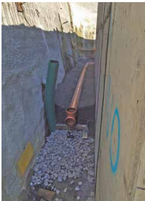
Figure 6.86 (à gauche): Détail du drainage de radon.
