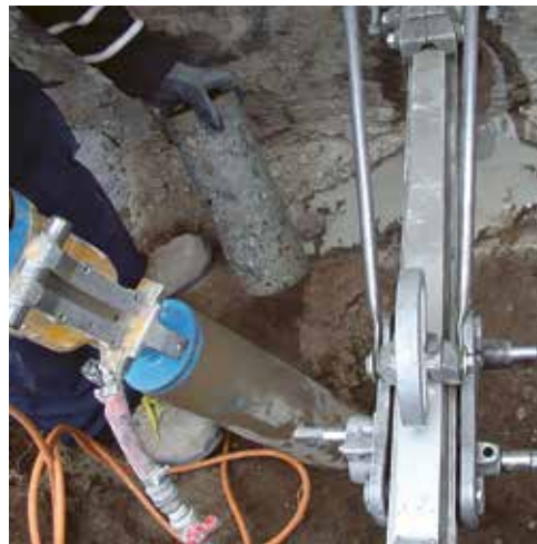
Figure 6.4: Pour le puisard extérieur, un percement a été effectué à côté de la maison et un autre sous la maison.
