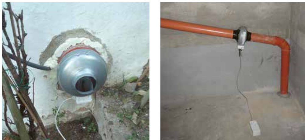
Figure 6.13 : Après avoir testé la ventilation du vide sanitaire (à gauche), un puisard intérieur a finalement été installé (à droite).
