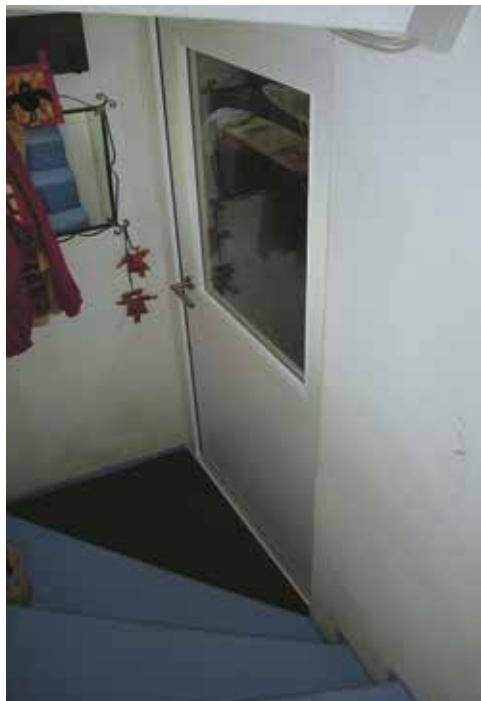
Figure 6.69 (à gauche): Le sol en terre battue de la cave à provisions est recouvert de briques perforées (perméables à l'air).
