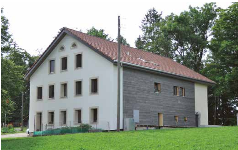
Figure 6.91 : La maison a été complètement rénovée selon Minergie.
