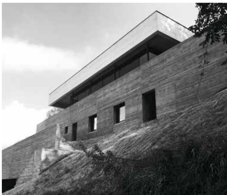
Figure 6.84 : Le rez-de-chaussée de la maison familiale est principalement entouré de terrain.
