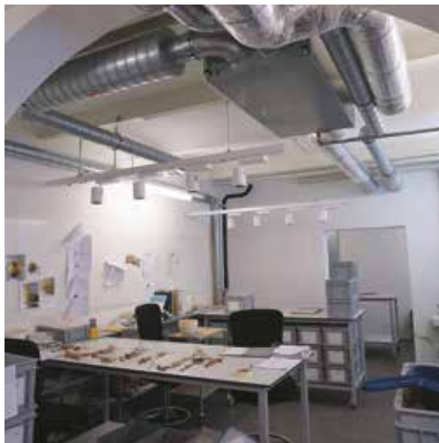
Figure 6.73: Les locaux du sous-sol sont utilisés en partie comme locaux de travail (à gauche). À droite, on voit l'aspiration ponctuelle du système de ventilation.
