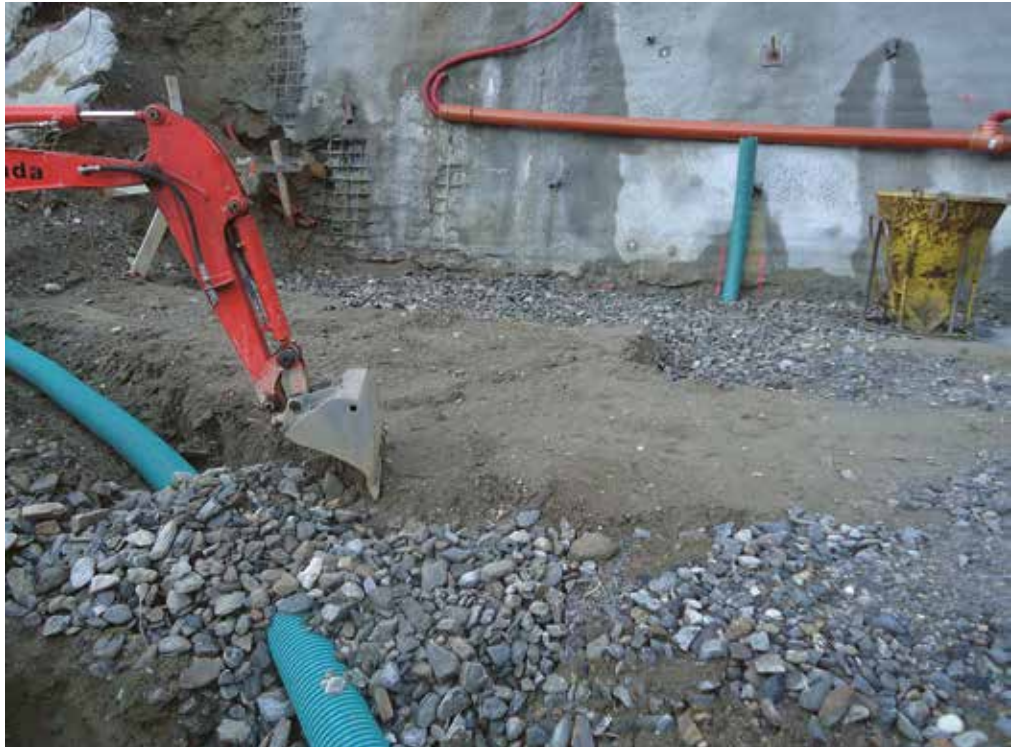
Figure 6.85 : Installation d'un drainage de radon.
