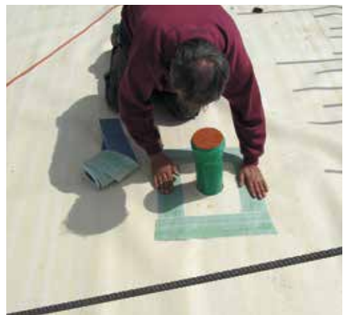
Figure 4.14 (à droite) : Détail relatif à l'étanchement d'un passage mural pour tuyau avant le coulage du radier (source : Sika).
