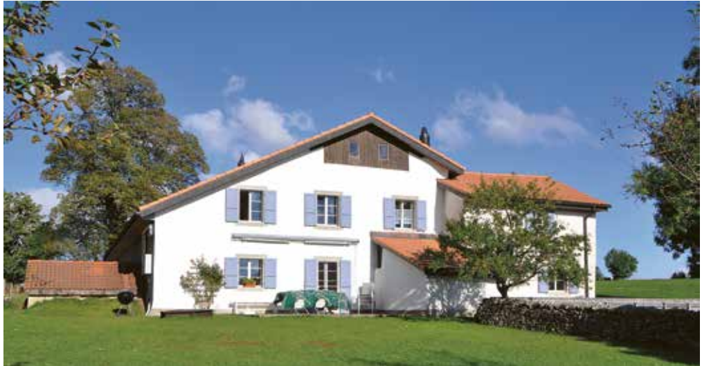
Figure 6.40 : Une ancienne ferme du 17 e siècle a été entièrement assainie en 2000.
