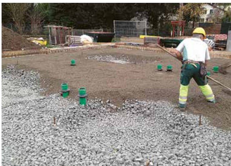
Figure 6.98 : Une couche de gravillon placée sous le radier sert de couche d'égalisation.
