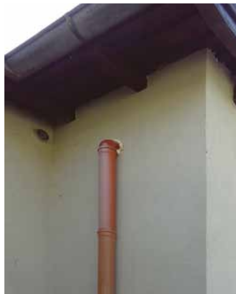
Figure 6.23: Pour des raisons de place et afin d'empêcher les émissions de bruit dans les chambres à coucher, un tuyau de ventilation a été monté à l'extérieur du bâtiment.
