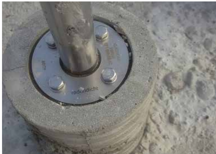
Figure 6.100 : Passage de tuyau bridé étanche au radon.
