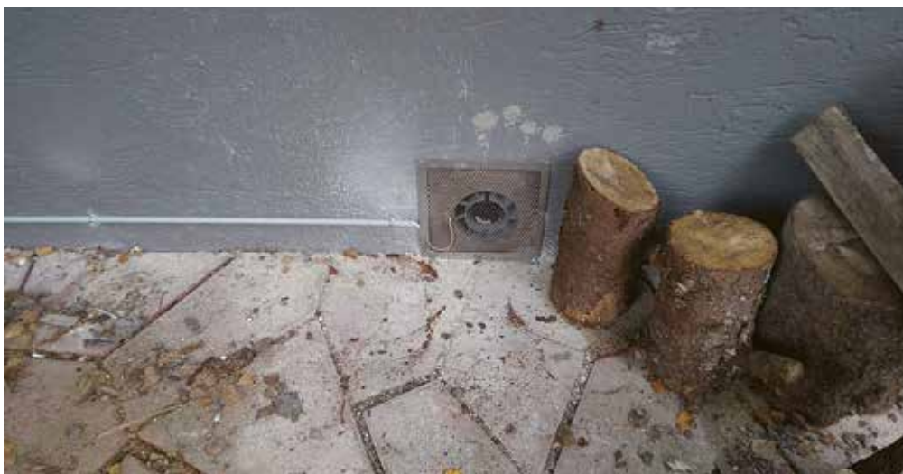
Figure 6.56 : Montage définitif du puisard.
