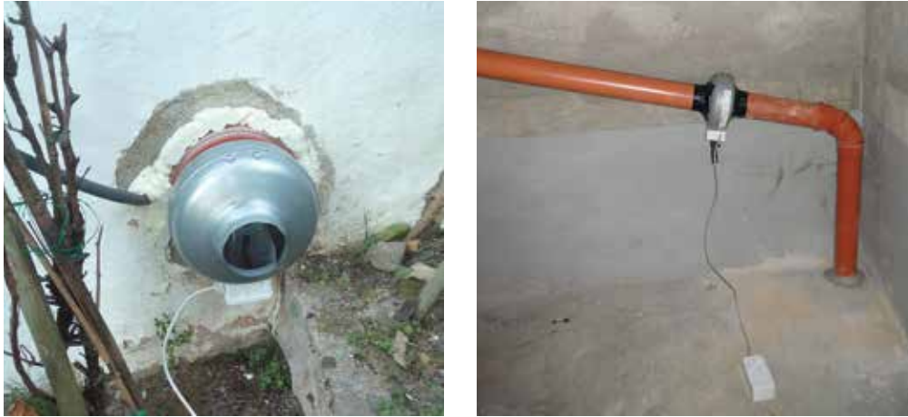
Figura 6.13: Dapprima è stata testata la ventilazione del vespaio. Infine si è deciso di costruire un pozzo radon interno (destra).
