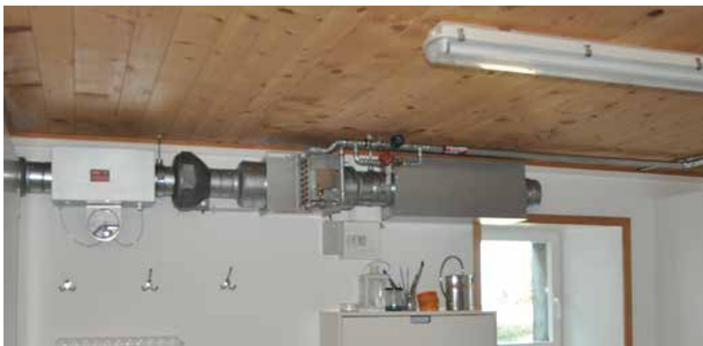
Figura 6.41: Installazione di un ventilatore per la messa in sovrappressione della lavanderia.
