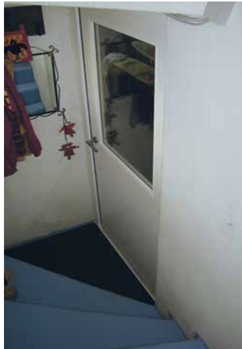
Figura 6.69 (sinistra): Il pavimento della cantina è coperto da sagomati forati permeabili all'aria.
