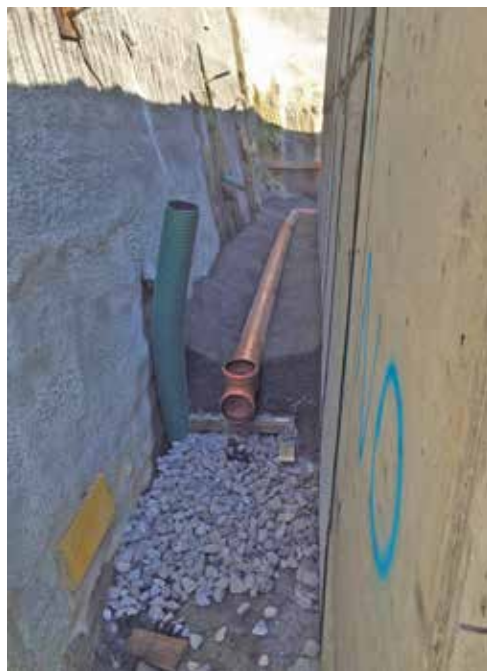
Figura 6.86 (sinistra): Dettaglio del drenaggio radon.
