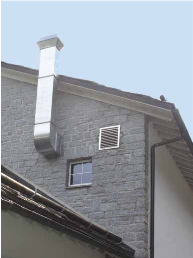
Figura 6.59: L'estensione della condotta di espulsione riduce al minimo il cortocircuito tra i flussi di ventilazione.
