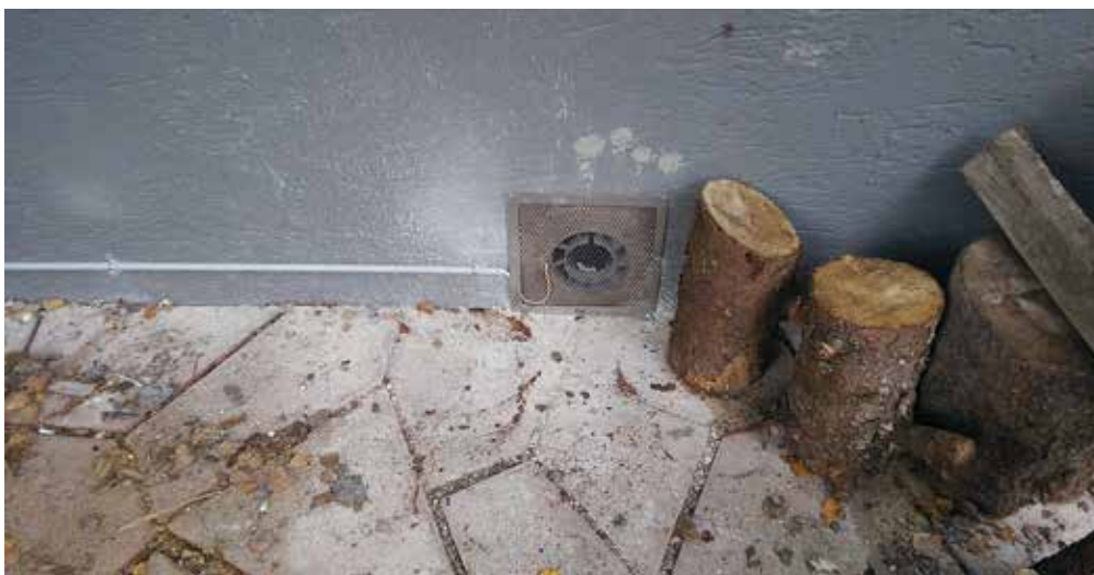
Figura 6.56: Esecuzione definitiva del pozzo radon.
