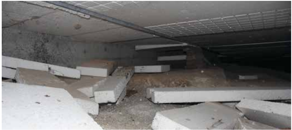
Figura 6.63: Sotto l'edificio scolastico (sopra) si trova un vespaio (sotto).
