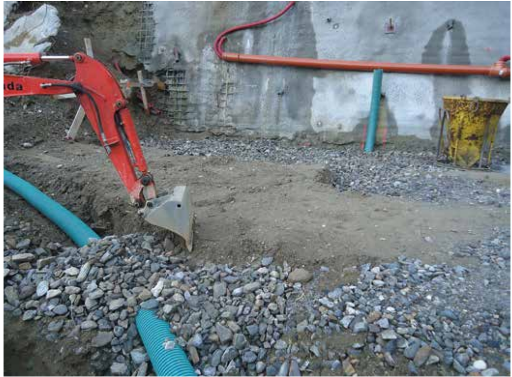
Figura 6.85: Installazione del sistema di drenaggio radon.
