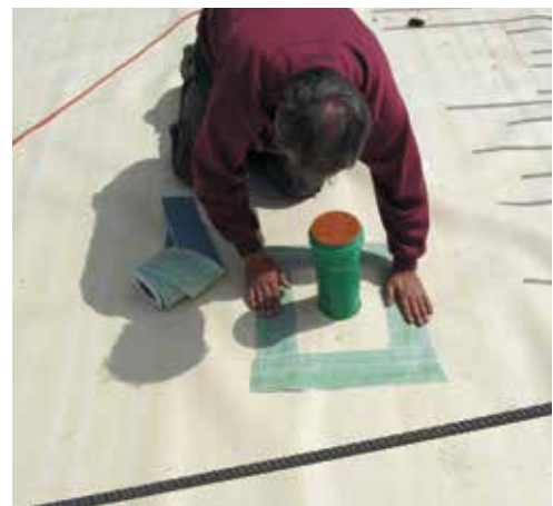
Figura 4.14 (destra): Dettaglio di sigillatura di una condotta passante prima del getto della soletta in cemento (Fonte: Sika).
