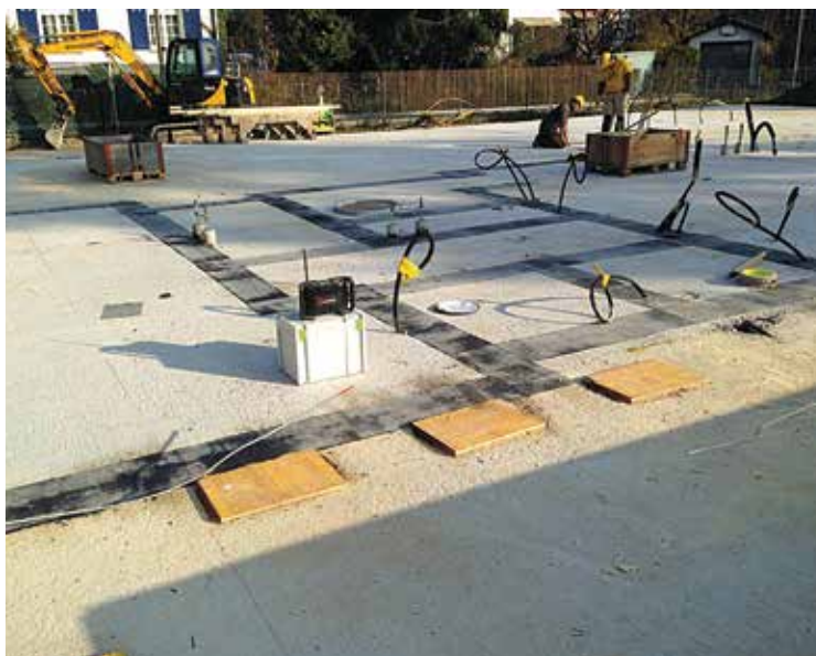
Figura 6.99: Interventi per la protezione dall'umidità e dal radon sul soffitto della cantina.
