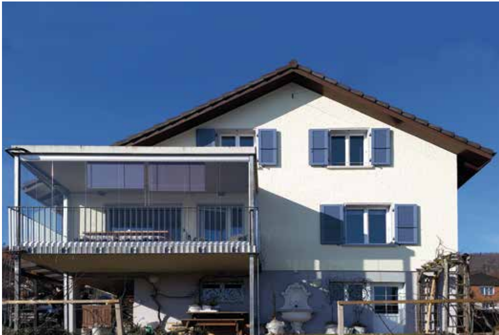
Figura 6.68: L'edificio è stato risanato nel 2009.
