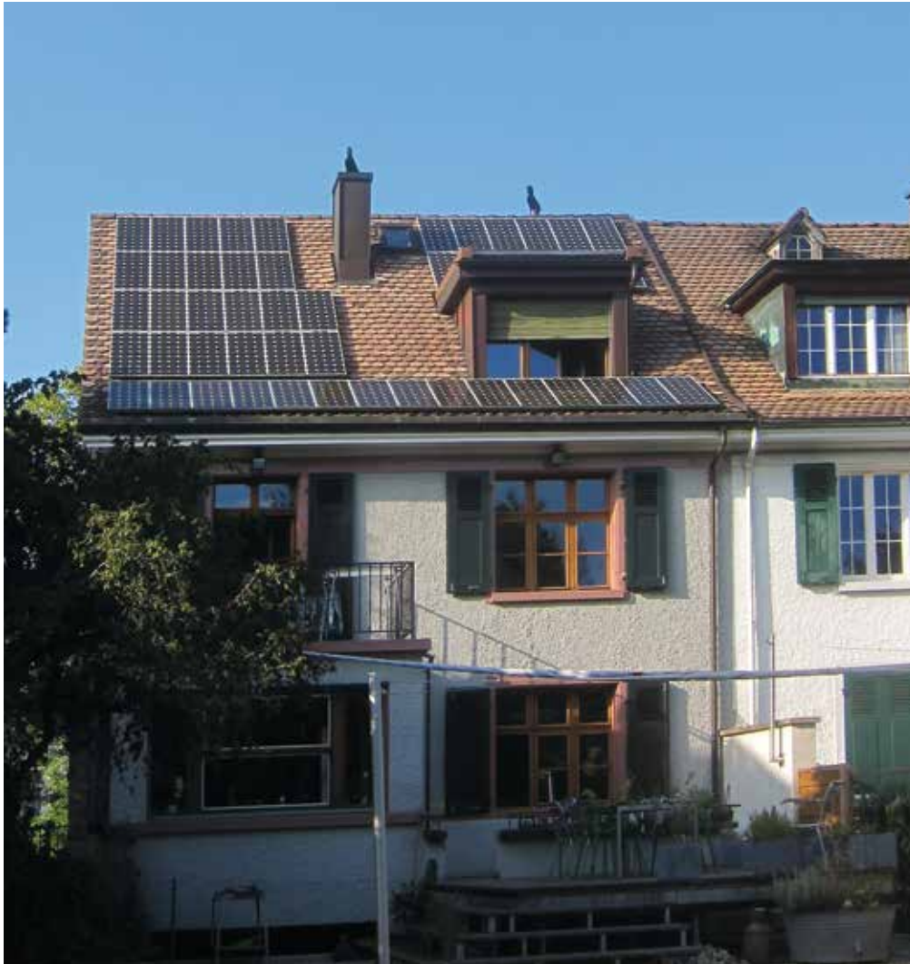
Figura 6.77: Nell'edificio degli anni venti, l'installazione di finestre ermetiche ha portato ad un aumento delle concertazioni.
