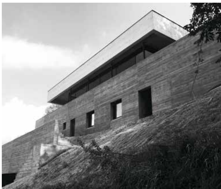
Figura 6.84: Il piano terreno della casa monofamiliare è principalmente a contatto diretto con il terreno.
