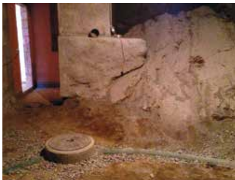
Figura 6.26 (sinistra): Platea di fondazione con tubo drenante: sullo sfondo si vede la roccia sporgere dal suolo affiorante.
