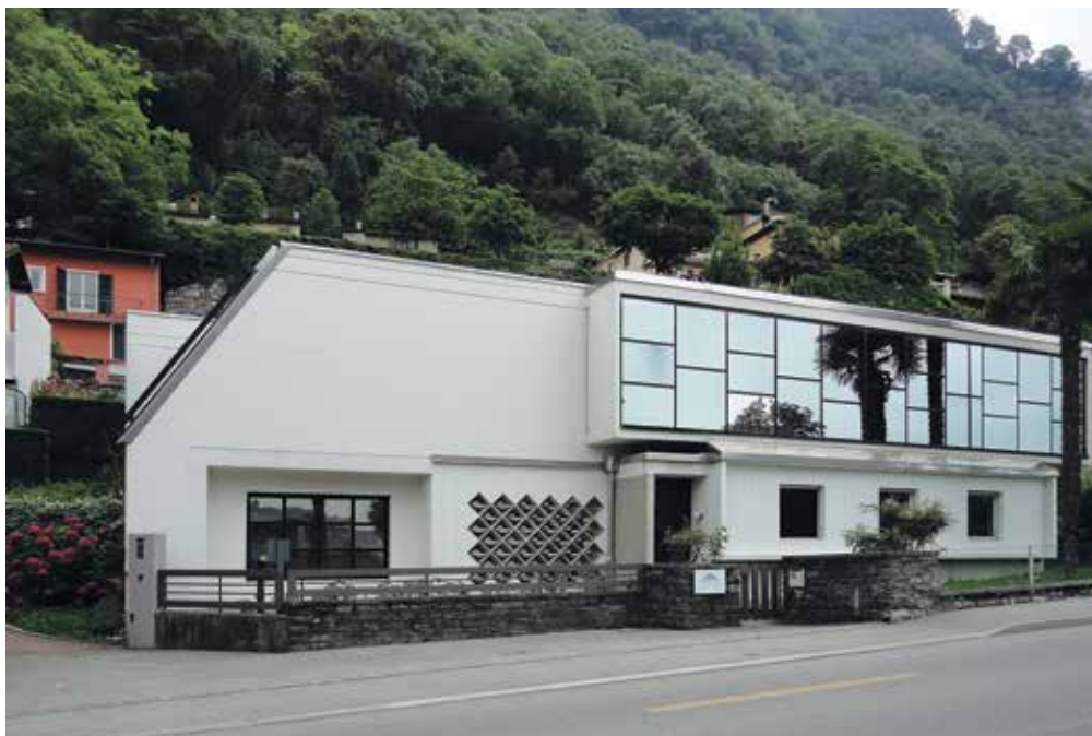
Figura 6.1 (sopra): L'edificio a due piani presenta punti non ermetici nella pavimentazione. Questo comporta valori radon elevati, soprattutto al piano terreno.
