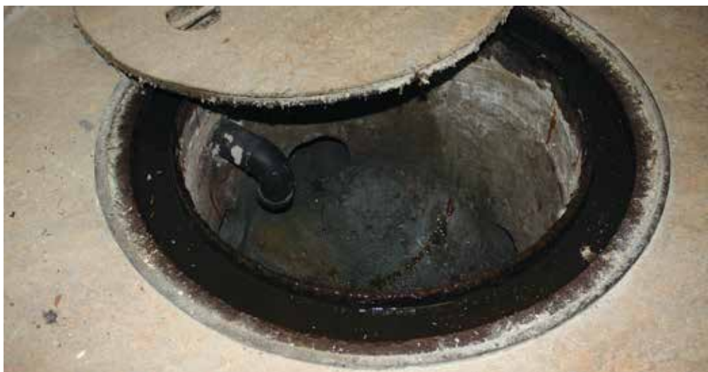
Figura 6.57: Apertura non ermetica nel pavimento del laboratorio situato al piano terra.
