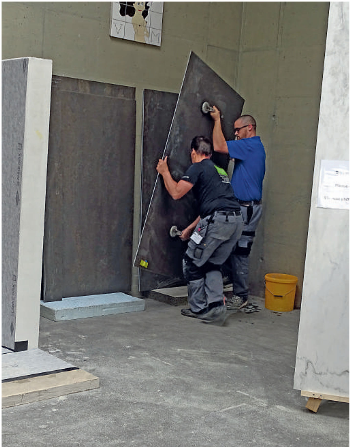
Solch grosse Platten können nicht mehr alleine bewegt werden, zwei bis vier Personen werden zum Verlegen benötigt.
